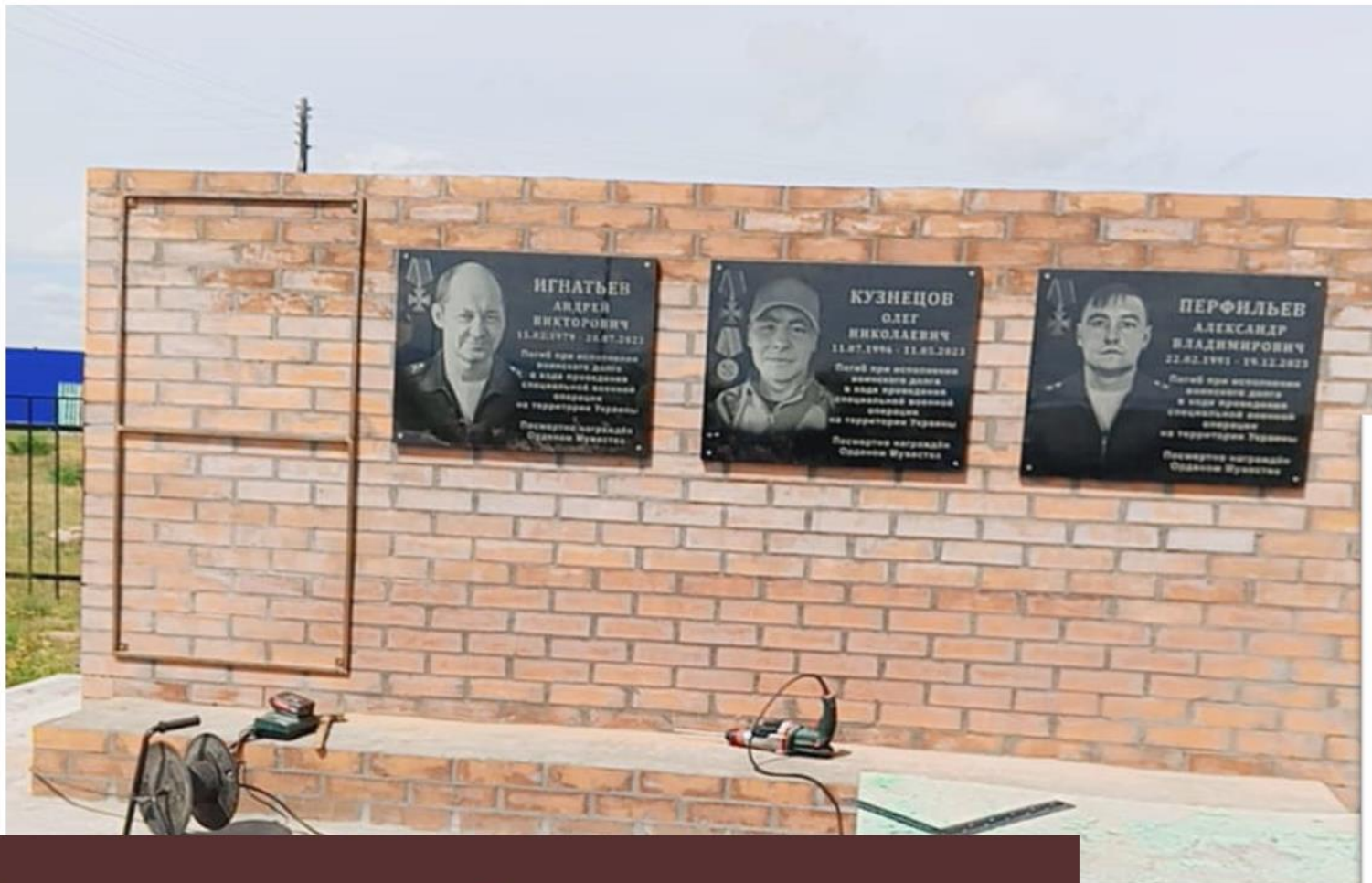
Строительство парка Памяти и установка стены по увековечению памяти о погибших при защите интересов Родины на Специальной военной операции
