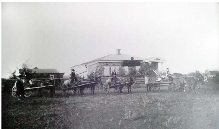
Пожарный обоз Большедербетовского улуса. Начало XX в.
