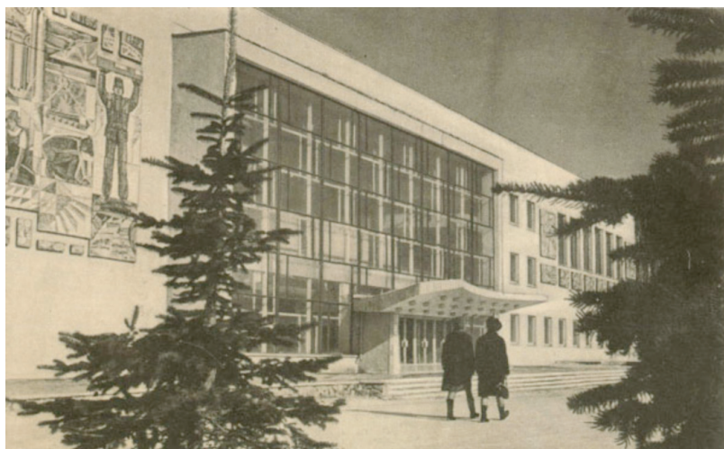
Илл. 6. Дворец культуры «Строитель».
