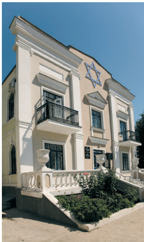
Здание синагоги ремесленников в Керчи, в котором ныне расположены еврейские организации города
